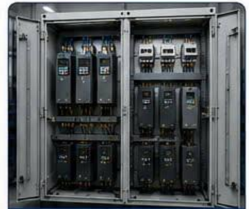
Tủ điện phân phối & biến tần hệ thống máy nghiền
