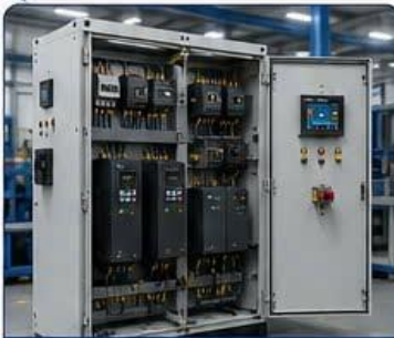
Tủ điện điều khiển & biến tần băng tải sản xuất
